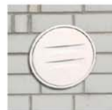
eingemauert in Wand
