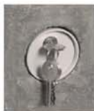
einbetoniert in Boden
